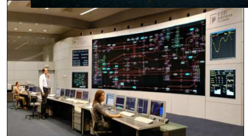
Windenergie im Kontrollzentrum
